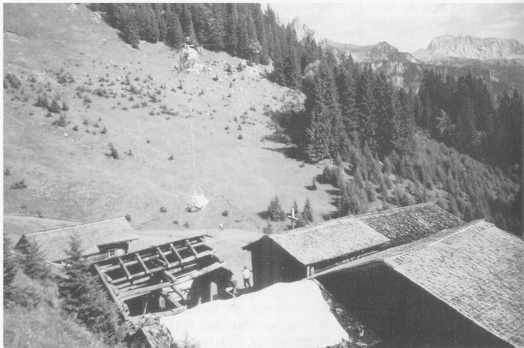
Abb. 32: Materialtransport mit dem Hubschrauber für die Gebäudesanierung auf Küngs
